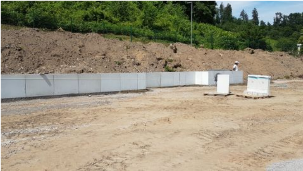
zweiten Kleinspielfeld die Mauerscheiben gesetzt werden...
