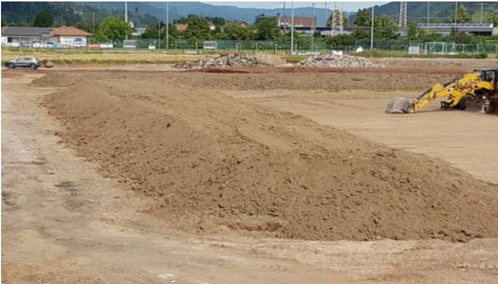
Hinten sind Berge von Asphalt und Betonplatten, davor die rote Erde. Der aufgehäufte Mutterboden um das Spielfeld wird wieder aufgebracht
