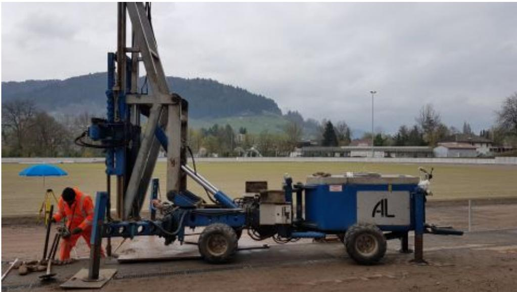
Am Standort der Masten wird ein Loch gebohrt, mit diesem urigen Gefährt ...
