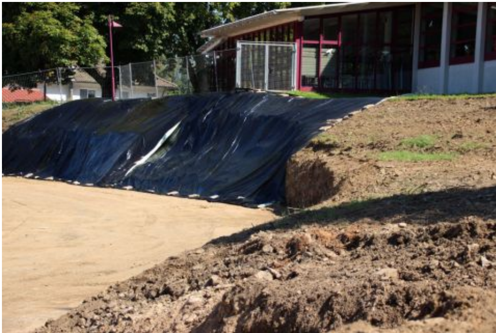
grüßen, die Antwort auf die Berliner Verhüllung heißt in Haslach Hangsicherung
