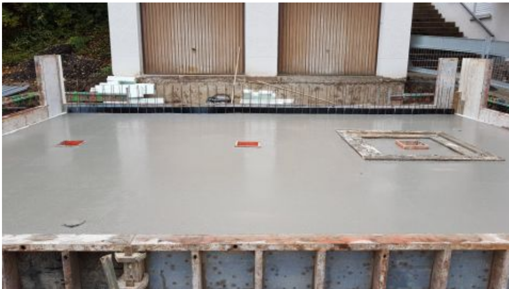
Die Bodenplatte für den Erweiterungsbau des SVH ist fertig
