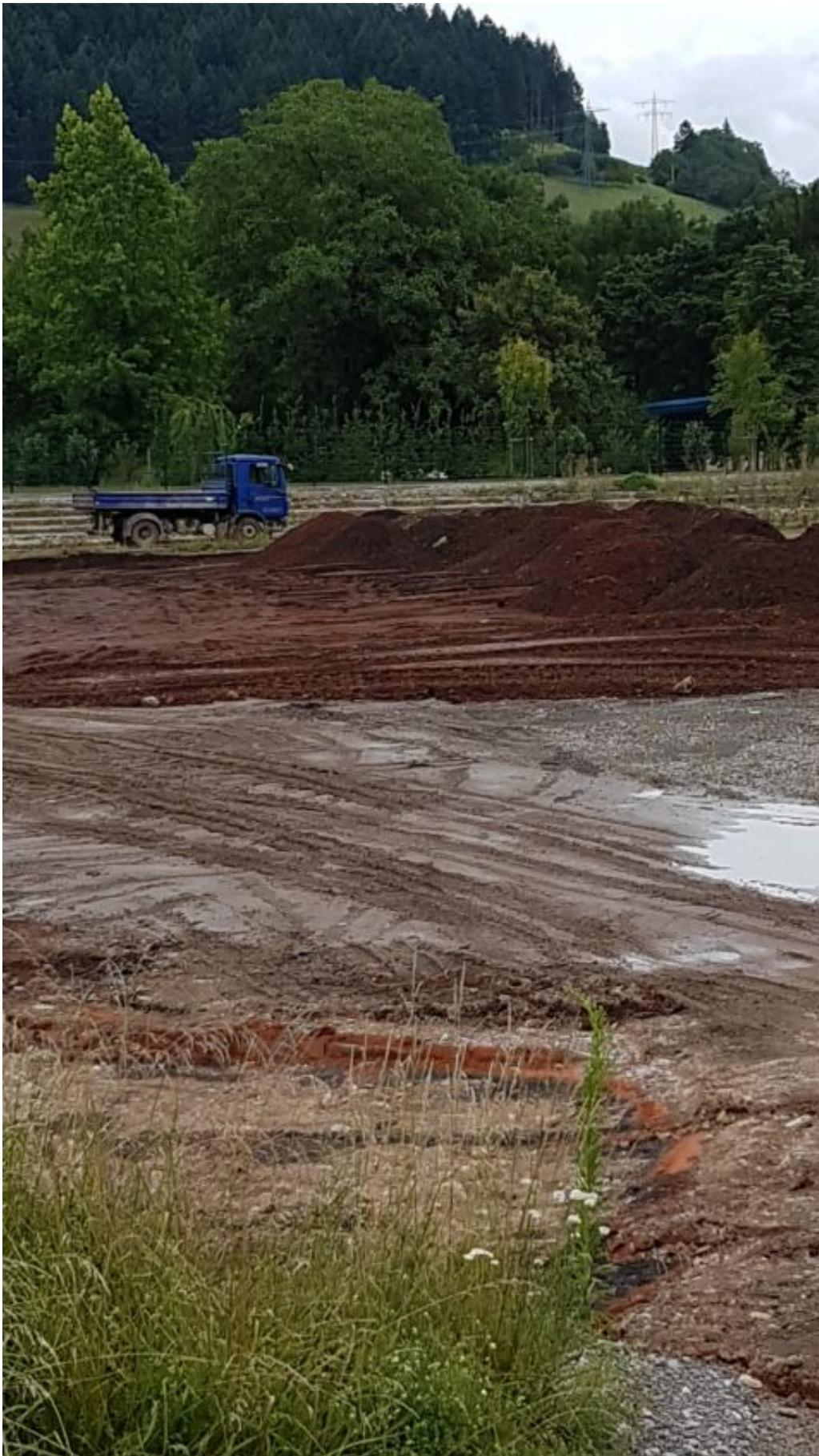
wird zwischengelagert und später als unterste Schicht wieder eingebaut
