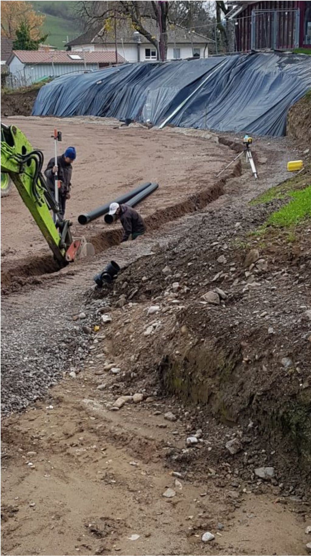
Entwässerungsröhre in der Kurve werden verlegt.
