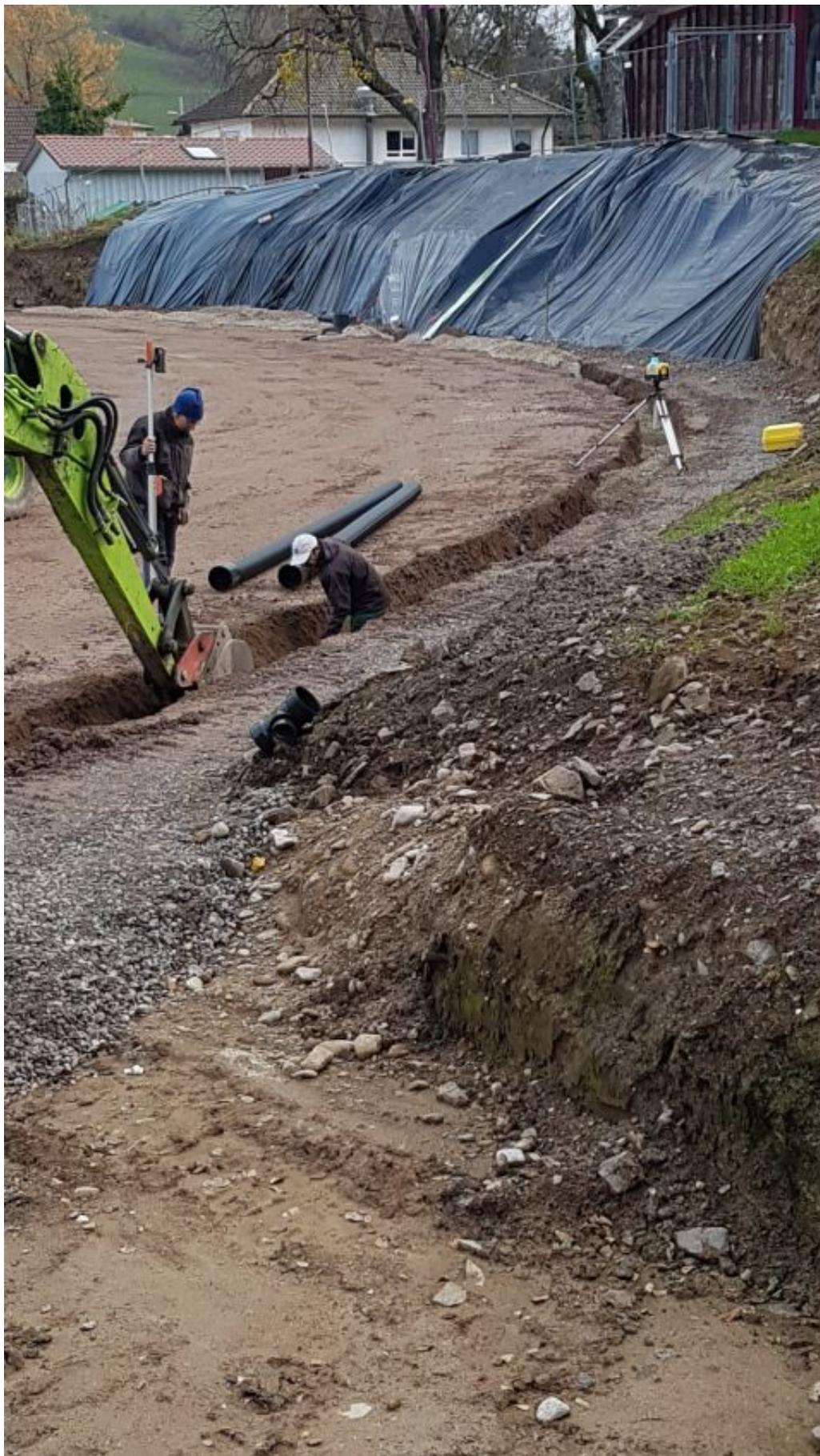
• Entwässerungsrohre in der Kurve werden verlegt.
